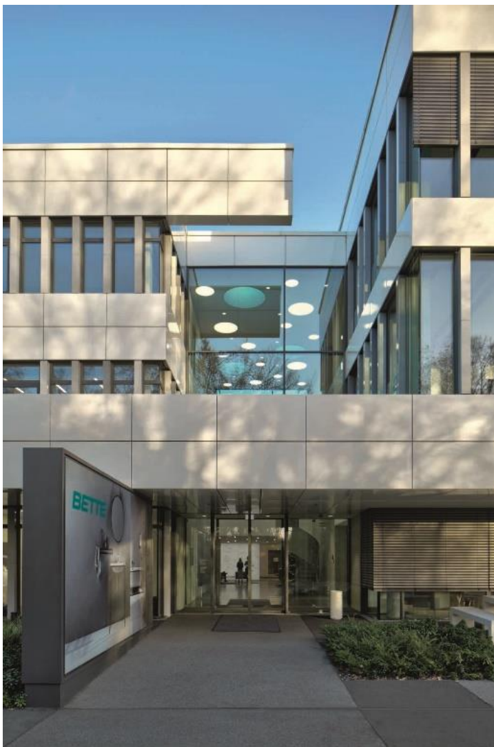
Abb. 2: Bauliche Hauptkriterien für die neuen Räumlichkeiten des renovierten Bette-Verwaltungsgebäudes waren die Steigerung des Raumklimakomforts sowie zeitgemäße energetische Kriterien.
