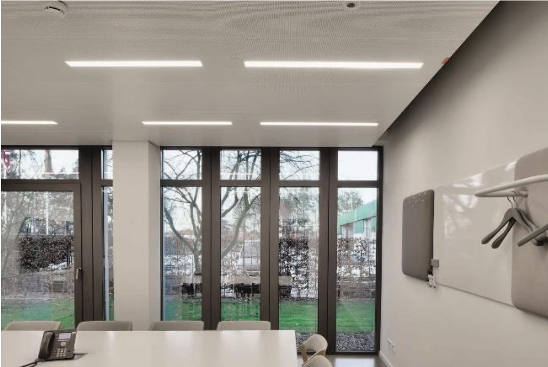
Abb. 3: Dank dem Strahlungsprinzip müssen die Zehnder Deckensegel nicht die gesamte Raumluft erwärmen. Die Infrarotstrahlen wandeln sich erst beim Auftreffen auf Gegenstände/ Körper in behagliche Wärme um. Somit wird ein deutlich niedriger Energieeinsatz von bis zu 40 % erreicht.
