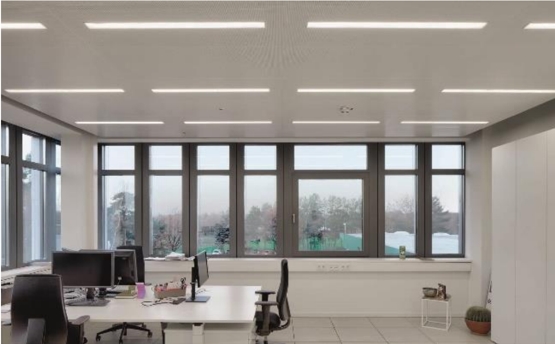
Abb. 4: Durch die hohe Wärmeleitfähigkeit des Werkstoffs Naturgraphit erreichen Zehnder Deckensegel besonders kurze Ansprechzeiten. Expandierter Naturgraphit eignet sich hervorragend, um Wärme in der Fläche schnell und gleichmäßig zu verteilen.
