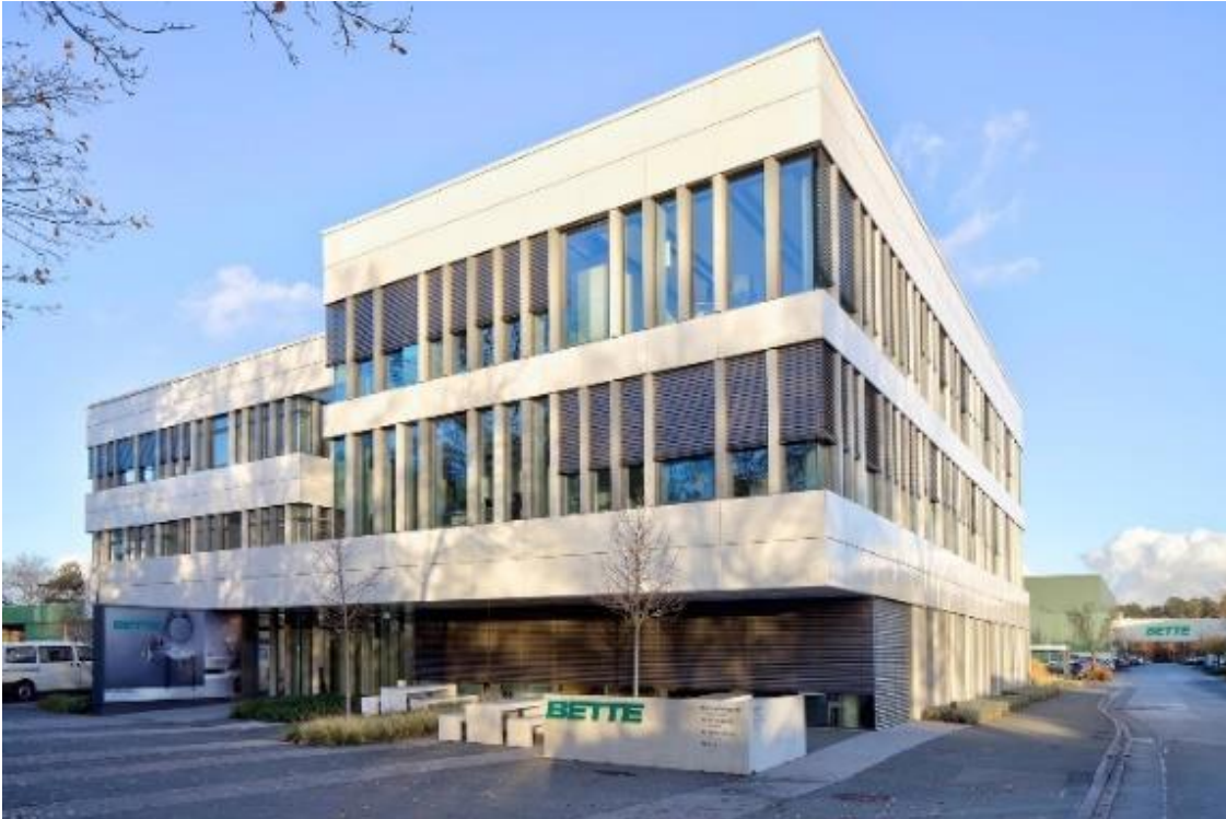
Abb. 1: Bette gehört in Europa zu den führenden Herstellern von Badausstattung. Am Hauptstandort der Firma in Delbrück wurde 2017 das Verwaltungsgebäude größtenteils kernsaniert bzw. neu gebaut.
