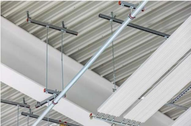
Bild 5: Die mittlere Montagehöhe der Zehnder Deckenstrahlplatten liegt bei ca. 8 m, leicht abgehängt bei einer Hallenhöhe von 9 m. Insgesamt wurden 1.200 laufende Meter an Deckenstrahlplatten auf einer Fläche von 6.000 m<sup>2</sup> verbaut. Mit dem speziellen Aufhängesystem von Zehnder konnten die Platten millimetergenau an der Decke installiert werden.
