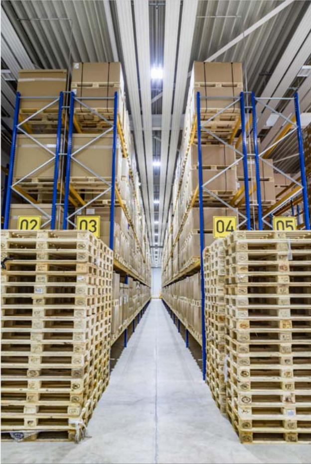
Bild 9: Die Zehnder Deckenstrahlplatten werden im Winterbetrieb mit einer maximalen Vorlauftemperatur von 38 °C und 30 °C Rücklauftemperatur betrieben, wodurch eine optimale Energieeffizienz gewährleistet ist. Im Sommerbetrieb liegt die Vorlauftemperatur bei 16 °C und die Rücklauftemperatur beträgt 18 °C. Für den Kühlfall wurde zudem eine Taupunktüberwachung installiert.
