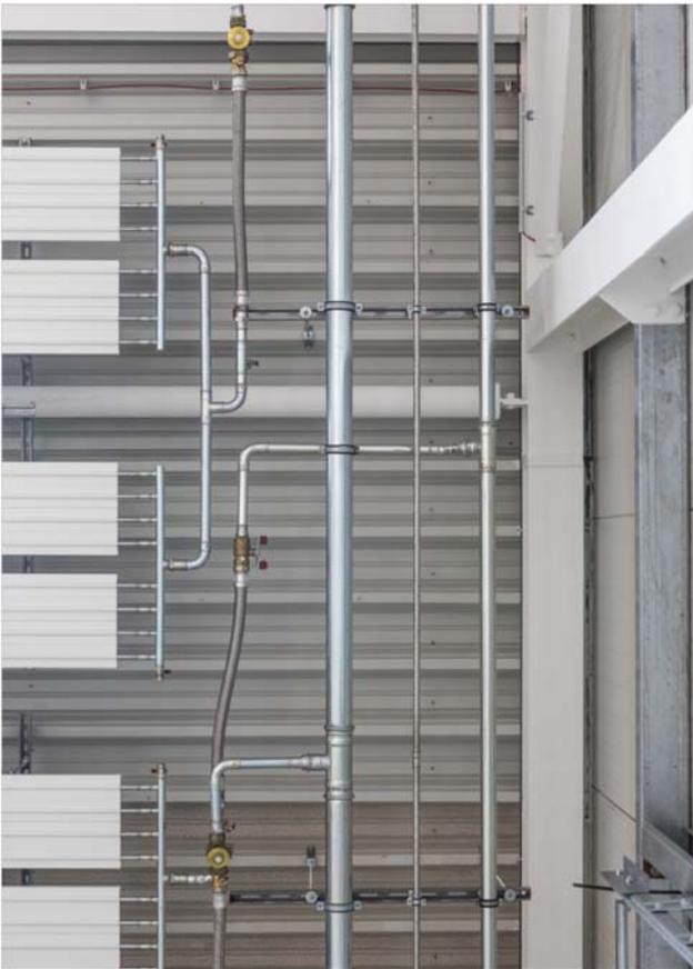
Bild 4: Das Heiz- und Kühldecken-System von Zehnder arbeitet dank Regelungstechnik vollkommen automatisiert: Die Deckenstrahlplatten werden im Sommer mit Kühlfunktion und im Winter mit Heizfunktion betrieben. Die genaue Umschaltung zwischen Kühl- und Heizfunktion erfolgt über die Raumtemperatur mit einem Temperaturfühler mit Berücksichtigung der aktuellen Wettervorhersage geregelt.
