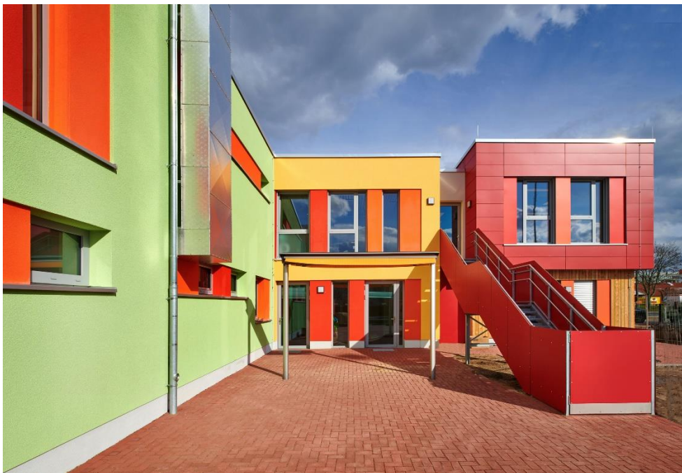
Bild 1: Kita in Laatzen in Holzbauweise
