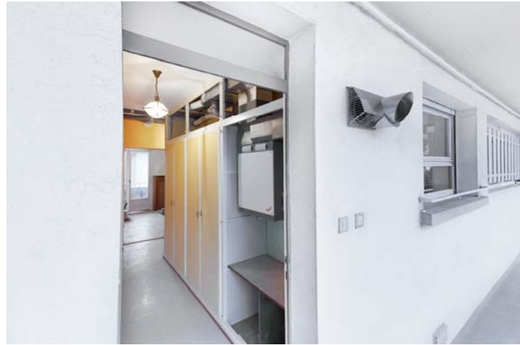
Bild 4: Im Zuge der Wohnungsrenovierung stellte der Einbau der Lüftungsanlage nur einen minimalen Aufwand dar: „Nach der Kernlochbohrung in die Außenwand ging alles ganz schnell“, bilanziert der Bauherr. Heute sieht man davon nur noch ein dezentes Auslassgitter an der Hauswand, sowie stilsichere Luftauslässe innerhalb der Wohnung.
