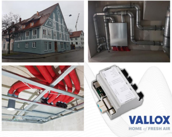
Bild (VALLOX GmbH): Denkmalgeschütztes Studentenwohnheim in Kempten mit einem Commercial Line Vario 1500 Zentralgerät, neun Flat Boxen und neuer Universal-Regelung
