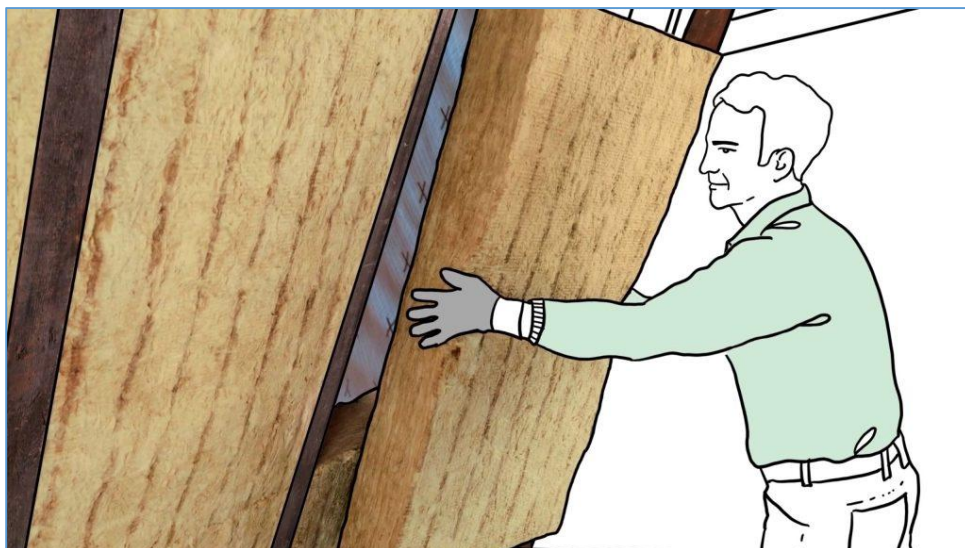
Bild 4: Dämmung unterm Dach: Eine Zwischensparrendämmung aus Mineralwolle lässt sich auch von Heimwerkern problemlos anbringen.
