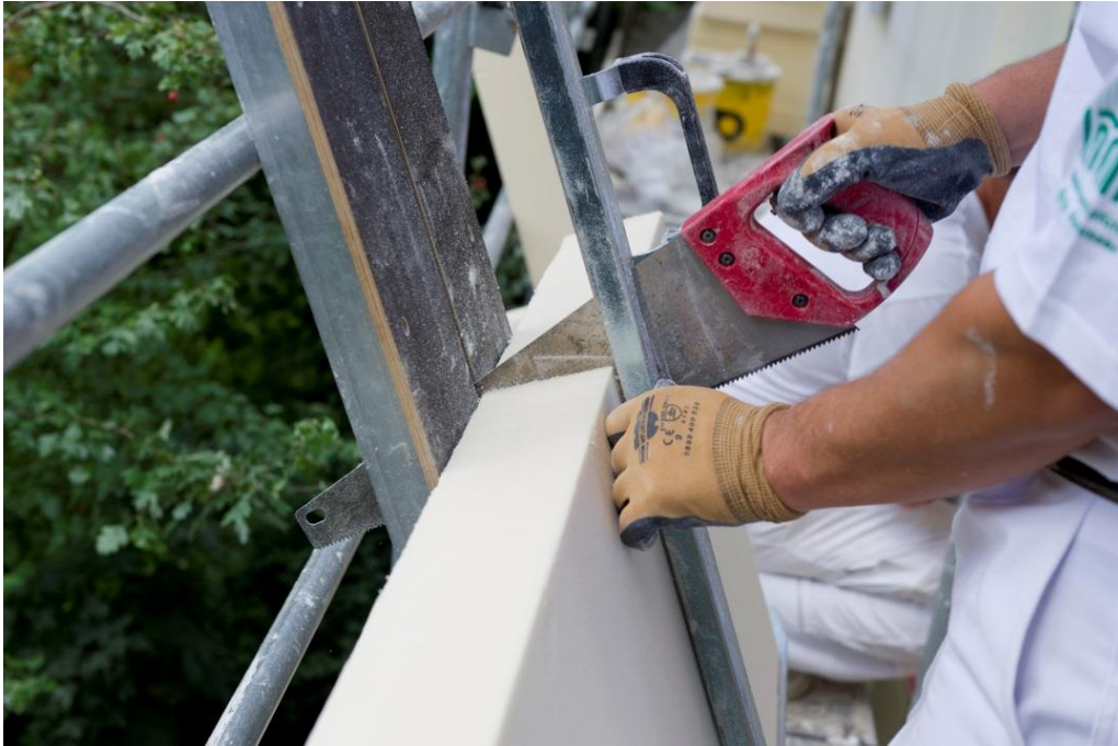
Bild 6: PU-Dämmplatten lassen sich auf der Baustelle leicht zuschneiden.
