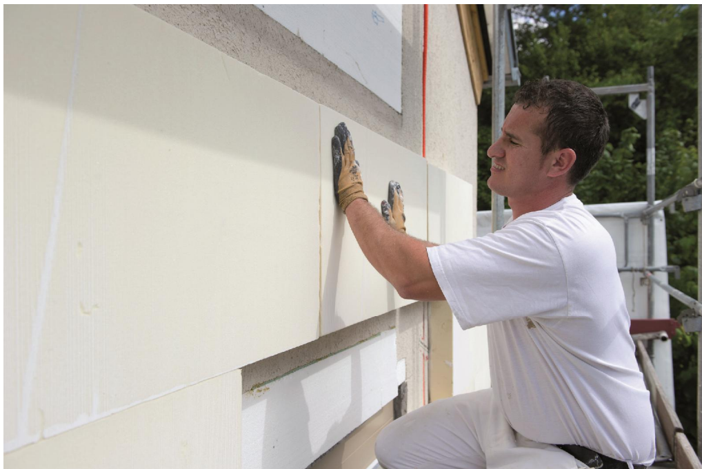
Bild 1: PU im WDVS sind bei gleichem Wärmeschutz bis zu 30 Prozent dünner als herkömmliche Dämmprodukte.
