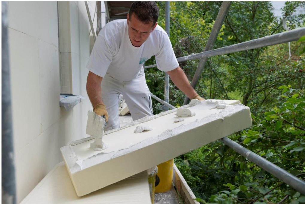
Bild 5: PU-Dämmplatten werden mit Klebemörtel im Punkt-Wulstverfahren aufgeklebt.
