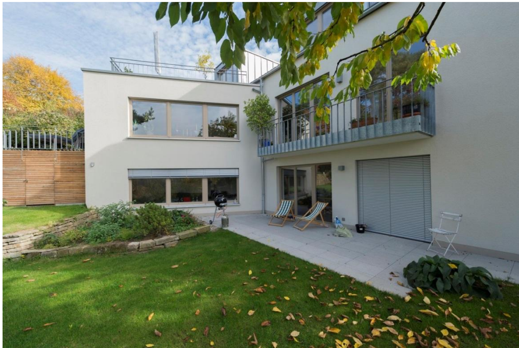
Bild 2: Jeder Zentimeter zählt: Geringe Laibungstiefen an Türen und Fenstern sorgen für mehr Lichteinfall, die Jalousie-Kästen lassen sich in das WDVS integrieren.
