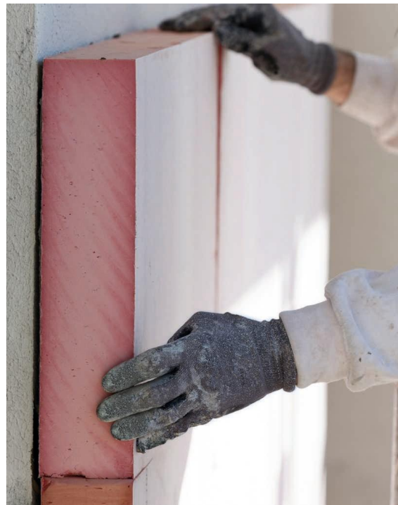
BU: Das WDV-System auf Resol-Hartschaum-Basis kann durchgehend verlegt werden. Der Einbau von zusätzlichen Brandriegeln entfällt. Foto: Saint-Gobain Weber
