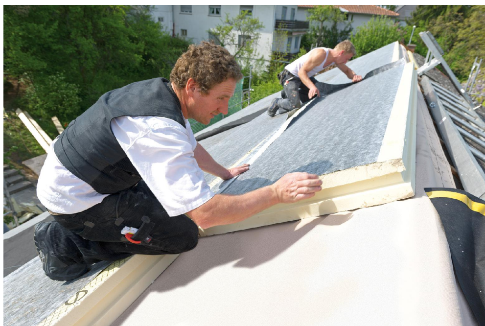
Bild 2: PU-Dämmsysteme haben eine aufkaschierte Unterdeckbahn. Es braucht deshalb nur einen Arbeitsgang für Wärmedämmung und Herstellung der Regensicherheit.
