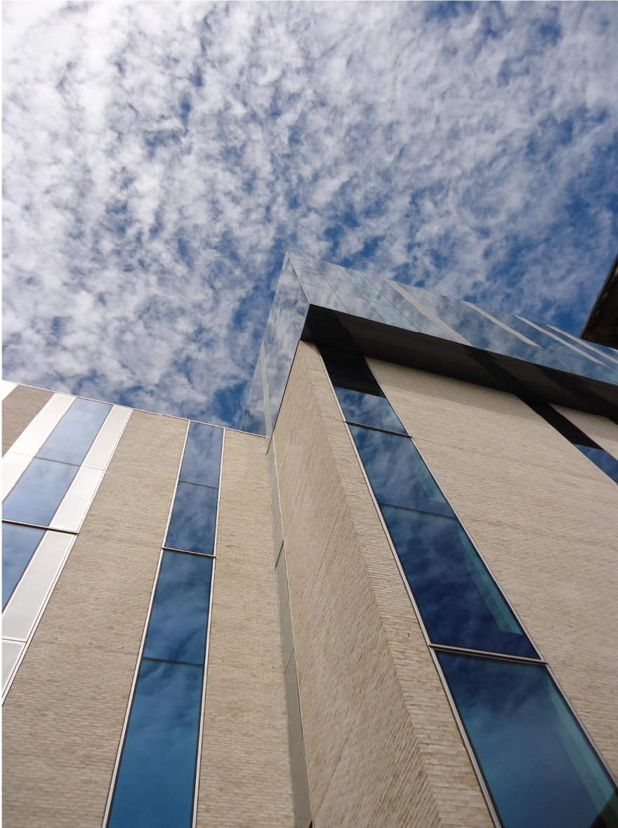
Bild 1: Raumhohe Verglasungen mit ipasol neutral 60/33 Sonnenschutzglas ziehen sich über die unteren sechs Etagen – darüber drei vollverglaste Stockwerke in exponierter Lage.
