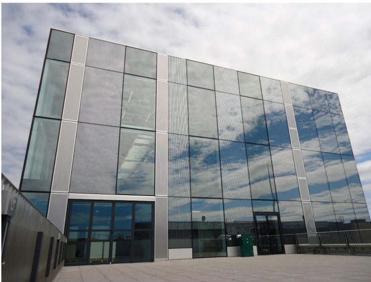
Bild 3: Die komplexe Glasfassade ist eine beispielhafte Zusammenarbeit der AGC Interpane Standorte Lauenförde und Plattling: In ihr wurden ipasol neutral 60/33 Sonnenschutzglas, Siebdruck und spiegelnde ipachrome-Teilbeschichtungen kombiniert. Foto: AGC Interpane
