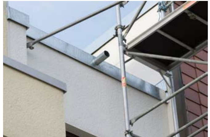
Entwässerung über ein Ablaufrohr in der Fassade
