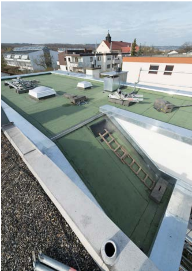
Flachdach mit angrenzender Dachschräge
