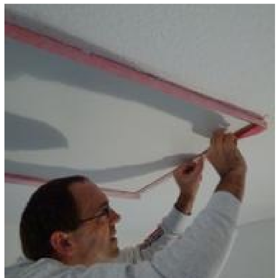
Bild 3: Einbau Deckenanschluss-System
