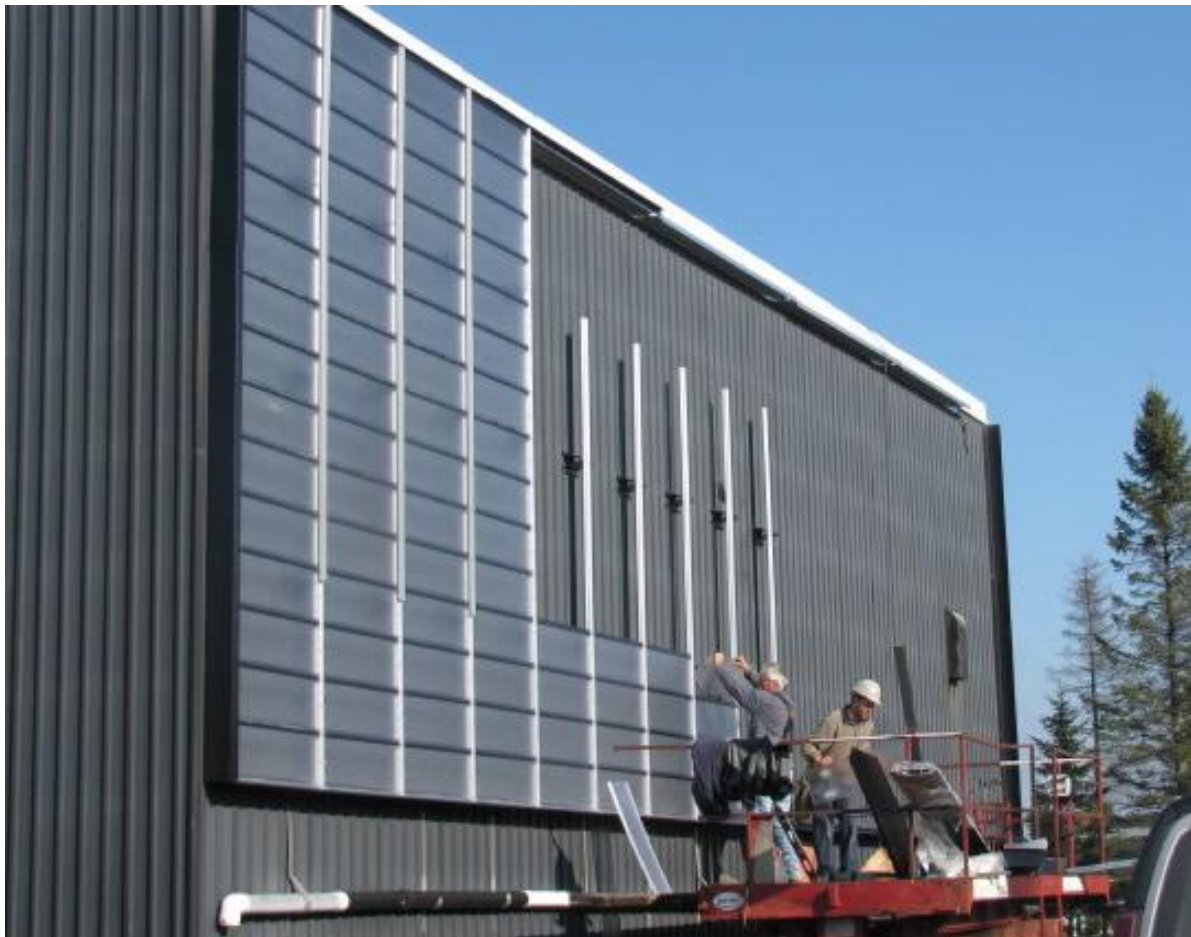
Bild 1: Energetische Gebäudesanierung zahlt sich aus, das Ergebnis sind Energieeinsparungen und Emissionsreduzierungen. Foto: GoGaS
