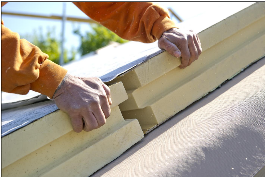
Bild 4: Eine lückenlose Aufsparrendämmung mit dem Hochleistungsdämmstoff Polyurethan garantiert angenehmes Raumklima unterm Dach auch im Sommer.
