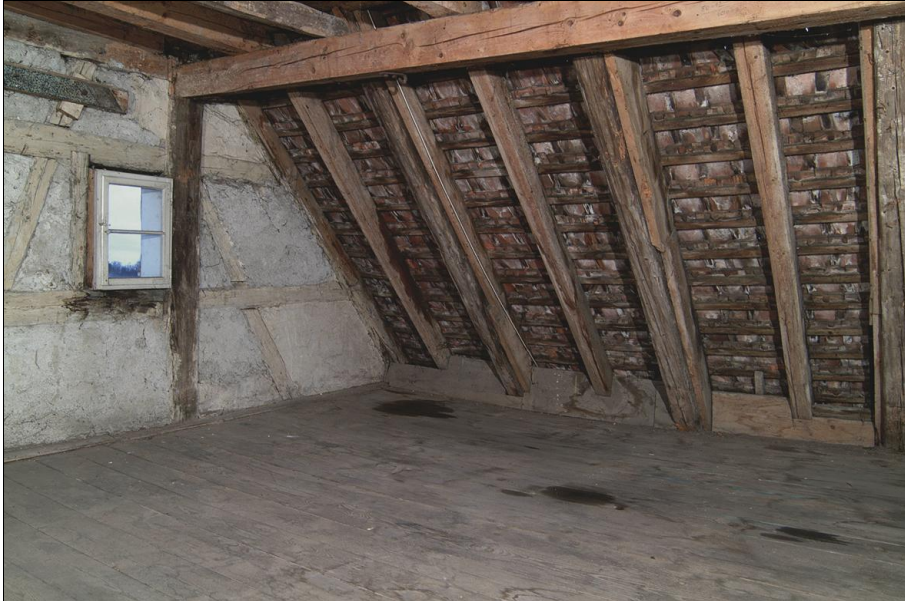
Bild 5: Wichtigste Maßnahme bei einem Dachausbau: Ein Wärmeschutz, der im Winter wie im Sommer für angenehme Temperaturen sorgt.
