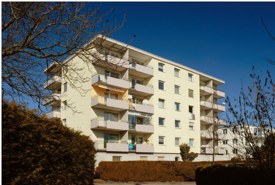
Bild 4: In den 47 Jahren, die seit der Dämmung dieses Mehrfamilienhauses im Vorarlberger Lustenau vergangen sind, wurde das Polystyrol-basierte Dämmsystem (StoTherm Classic) lediglich einmal überstrichen.
