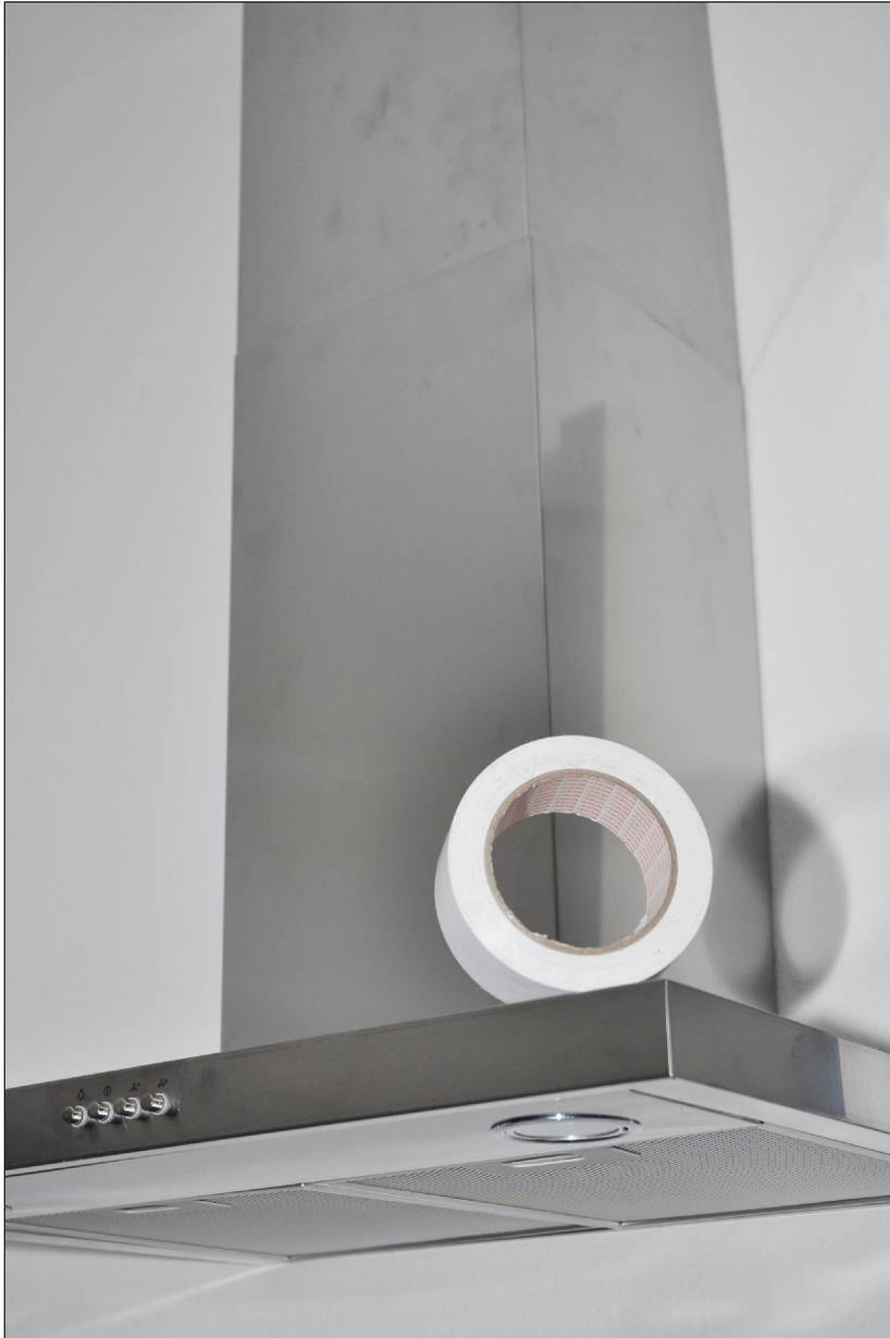
**Bild 1: Offen lassen, verschließen oder ganz abdichten?** Die Frage, wie man bei Luftdichtheitstests mit Gebäudeöffnungen wie dieser Abzugshaube umgehen soll, wird auch mit der jüngst verkündeten EnEV 2014 nicht klarer, befürchtet der Fachverband Luftdichtheit im Bauwesen e. V.
