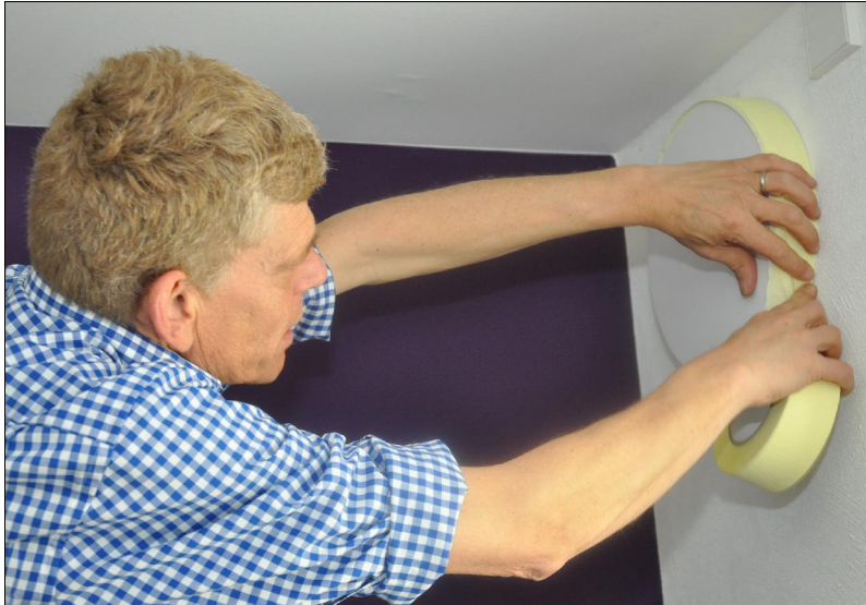
Bild 1: Luftdurchlässe von ventilatorgestützten Lüftungssystemen werden für den Dichtigkeitstest abgedichtet, wenn sie beim EnEV-Nachweis rechnerisch berücksichtigt wurden.
