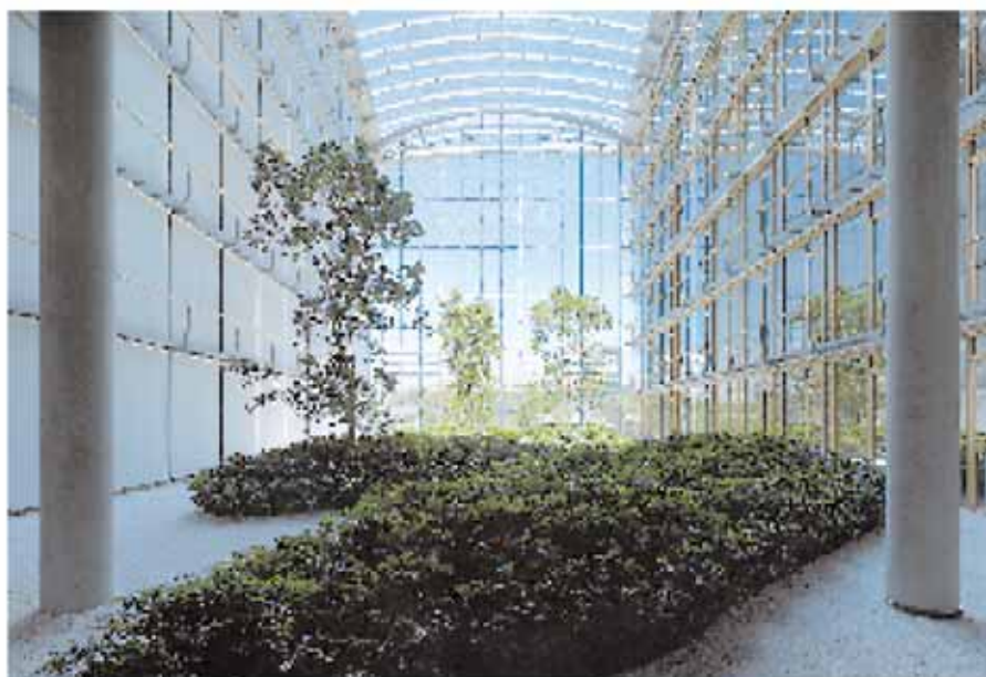
Eine Glasgitterschale überwölbt die Gärten. Diese wirken als Kälte- und Wärmepuffer und schützen vor zuviel Lärm
