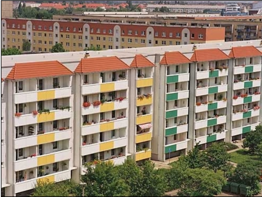
Bild: Sanierte Gebäude in Leipzig
