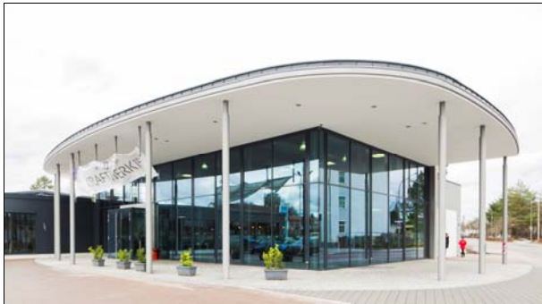
Bild 1: Das Fitnessstudio „Kraftwerk 151“ in Friedberg bei Augsburg ist einer der Kunden von Walter Fichtel, Geschäftsführer der Schäffer Haustechnik GmbH. Um eine optimale Wohlfühlatmosphäre beim Trainieren bieten zu können, ließen die Betreiber Lüftungssysteme von Zehnder installieren.
