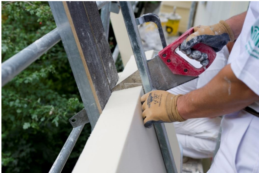
Bild 6: PU-Dämmplatten lassen sich auf der Baustelle leicht zuschneiden. Bildquelle: IVPU
