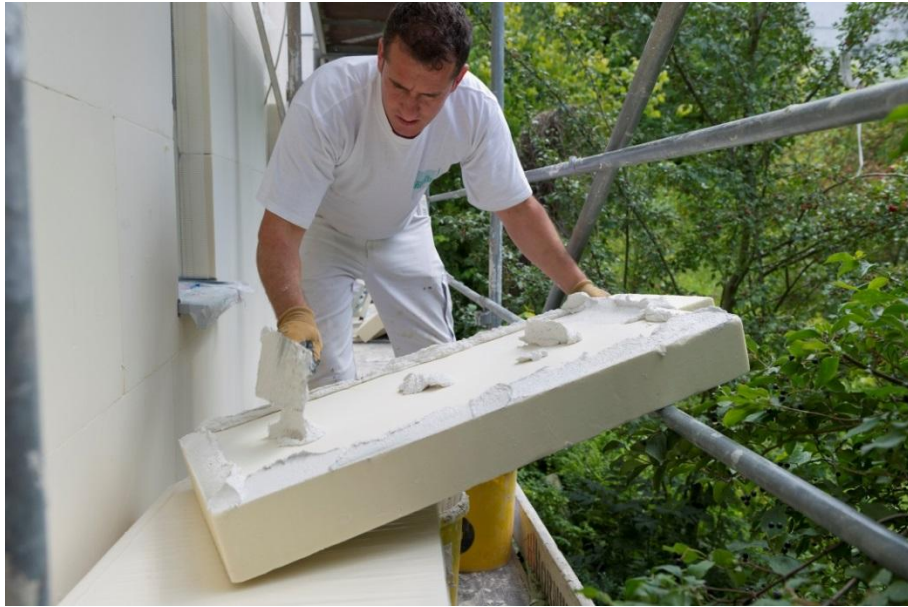
Bild 5: PU-Dämmplatten werden mit Klebemörtel im Punkt-Wulstverfahren aufgeklebt. Bildquelle: IVPU
