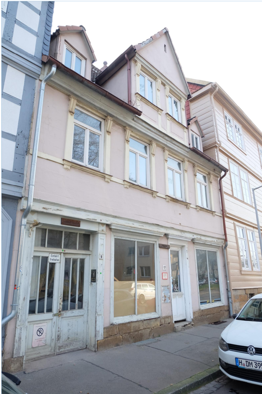
Bild 3: Altbau aus dem Jahr 1680, der 2017 umfassend energetisch saniert wird. (Bildquelle: enercity-Fonds proklima)
