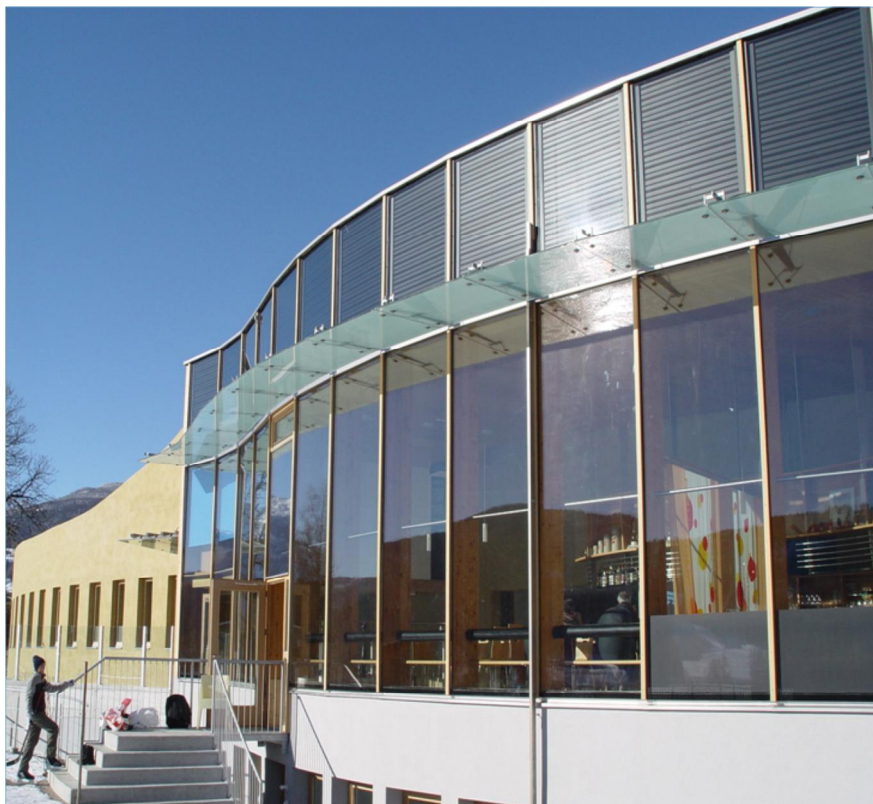
Bild 2: Gebäude mit multifunktionaler Fassade: Optisch ansprechend, lichtdurchlässig und energiegewinnend. (Bildquelle: Ingo Gabriel)
