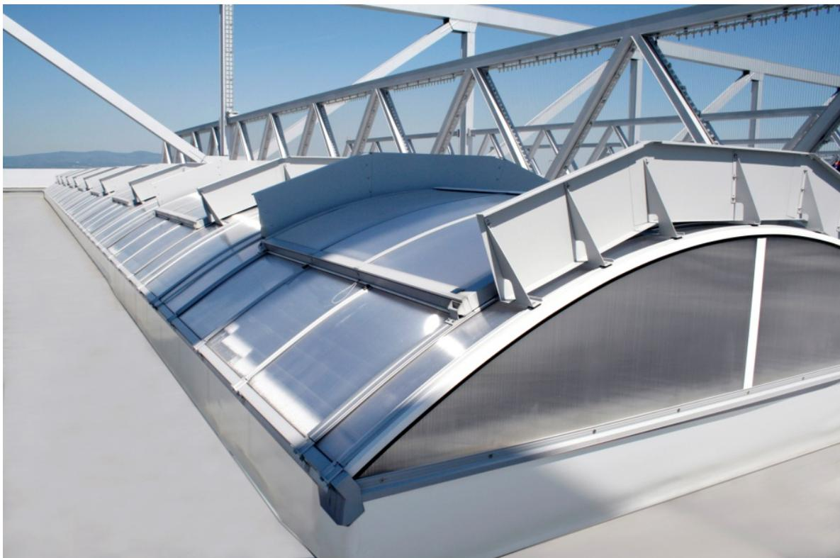
**BU:** Lichtbänder bieten Komplettlösungen rund um Tageslicht, Rauchabzug und Lüftung
