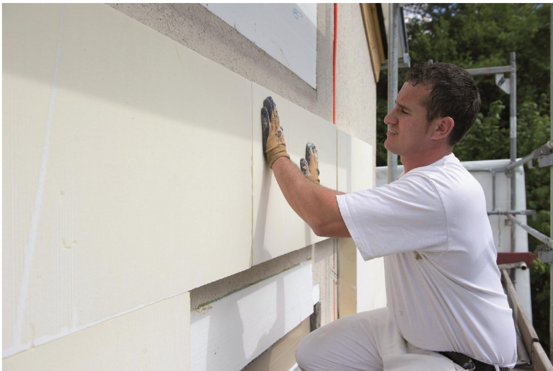
Bild 1: PU-Dämmstoffe im WDVS ermöglichen schlanke Aufbauten bei hoher Dämmleistung.
