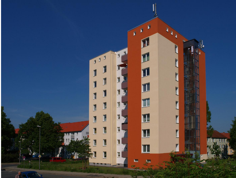
Bild 1: Zeitgemäß sanierte Wohnbauten aus den 1950er/1960er Jahren sparen Energie, sehen gut aus – und werden nachgefragt.
