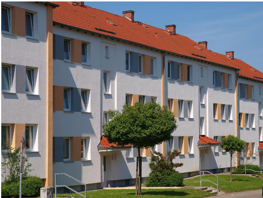
Bild 2: Die Wohnbau Salzgitter GmbH hat große Teile ihres Bestandes durch gezielte energetische Sanierung zukunftsfähig gemacht.
