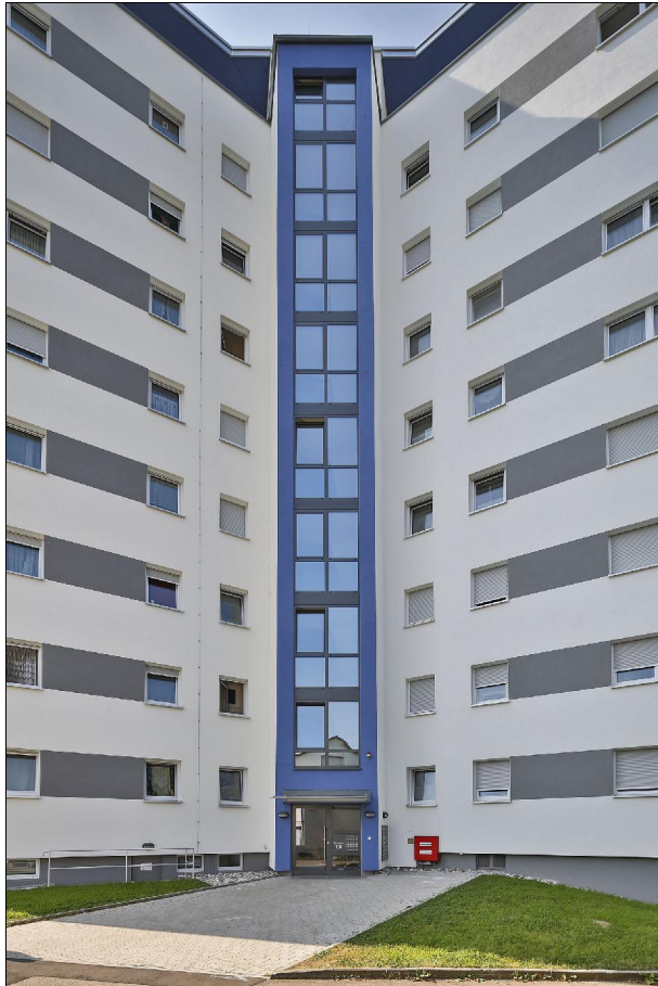
Bild 2: Neben den Balkonbrüstungen tragen auch die Dachuntersichten und die Treppeneinfassungen Farbe.
