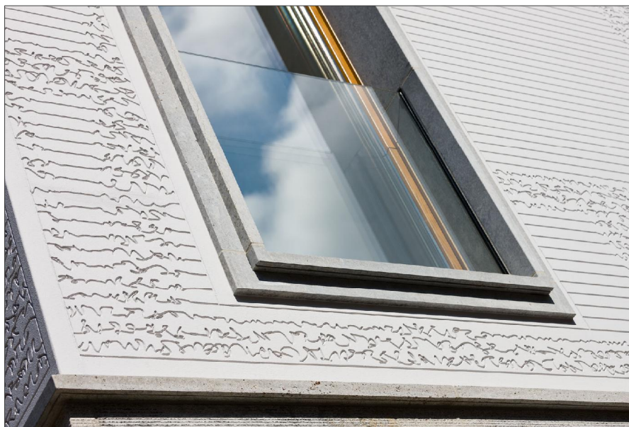
Bild 4: Rangezoomt: Aus der Nähe wird der Verlauf des „Darmstädter Zitterstrichs“ ablesbar, die Struktur des Fachwerks löst sich auf. Für die eindrucksvolle Fassadengestaltung kamen mineralische Platten zum Einsatz, die nach einem vorher definierten Algorithmus von einer CNC-Fräse bearbeitet wurden.
