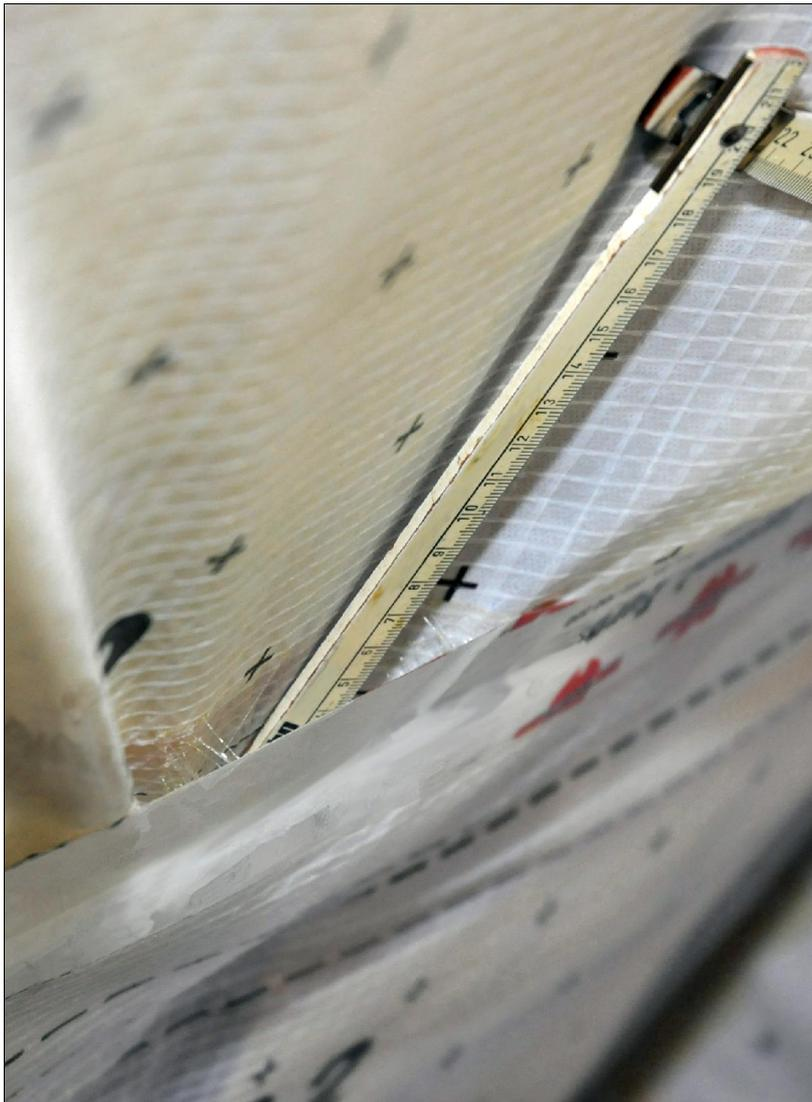
Bild 1: Ist diese fehlerhafte Verklebung kritisch? Je nach Blickwinkel und Einzelfall kann man zu unterschiedlichen Ergebnissen kommen. So ist es durchaus möglich, dass sie weder nennenswerte Lüftungswärmeverluste noch Zugluft verursacht und dennoch Ursache eines Bauschadens wird. Foto: FLiB e. V.
