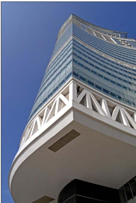
Bild 2: Geschwungene Formen. Der japanische Stararchitekt Kisho Kurokawa gab dem Fusionopolis sein einzigartiges Äußeres. Die Structural Glazing Vorhangfassade widersteht hohen Windlasten und schützt mit ipasol Sonnenschutzglas vor der äquatorialen Hitze Singapurs. Foto: Interpane
