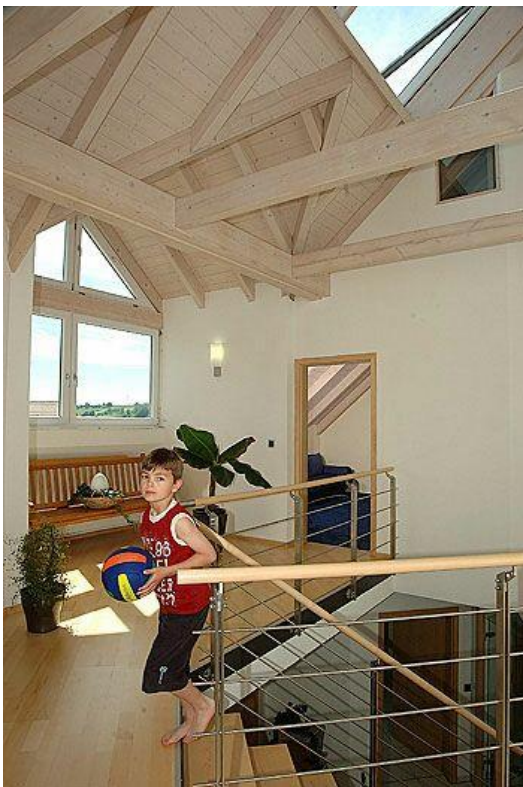
Abbildung 1 Großflächige Verglasung bedeutet viel Wärme im Sommer
