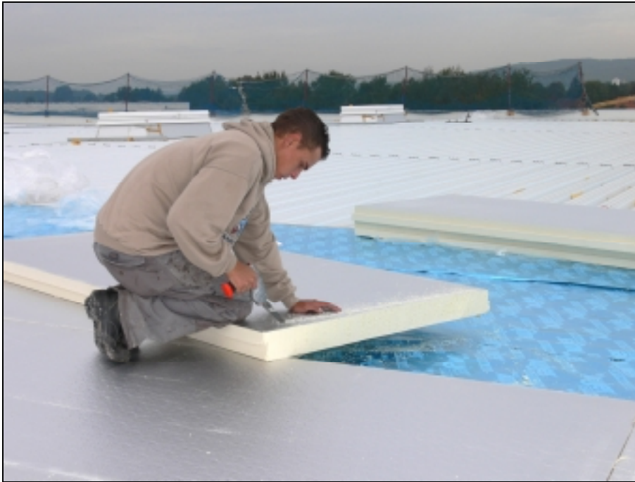
Bild 3: Polyurethan-Hartschaumstoffe gelten unter Experten als Dämmweltmeister. Die leichten PIR-Dämmplatten können einfach, schnell und kostengünstig verlegt werden.
