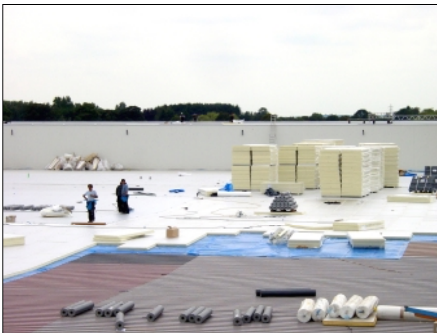
Bild 2: Fachgerecht geplant, gedämmt, abgedichtet und entsprechend gewartet überdauern Industrie-Leichtdächer über Jahrzehnte. Polyurethan weist ein geringes Gewicht und Volumen auf. Die Tragkonstruktion des Daches kann schlanker dimensioniert werden.
